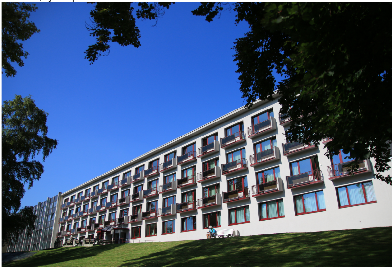
Vue de la façade après les travaux d'isolation
